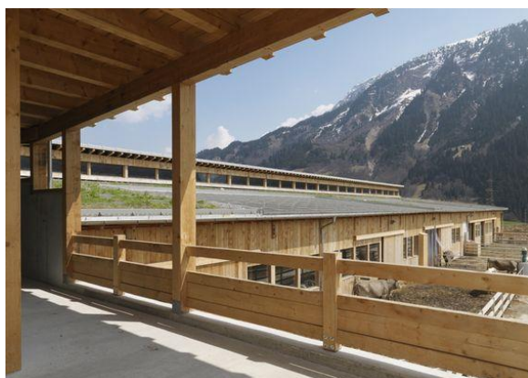
Bâtiment d'élevage en Suisse, Gion Caminada architecte
