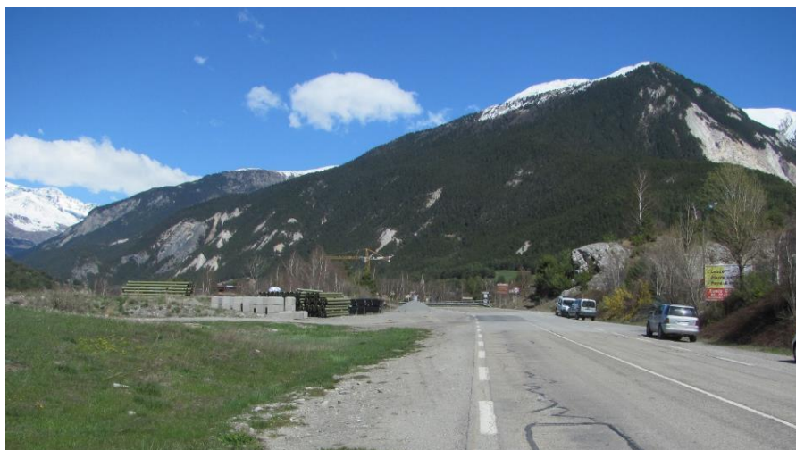
Photo 39 : Stationnement des véhicules linéairement à la voie au sud de la RD (à droite) et dépôt de matériaux et stationnements au nord (à gauche)
