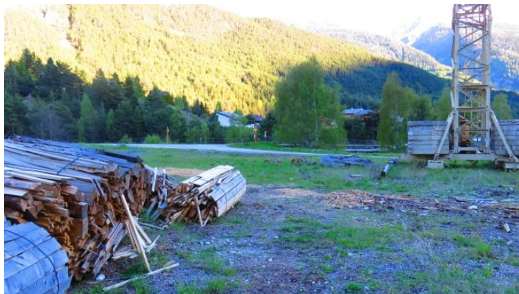
Photo 30 : Plateforme d'entrepôt de gravillons et plantes rudérales
