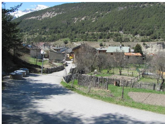
Photo 27 : Vue 3, depuis l'amont dans le virage formé par la route
