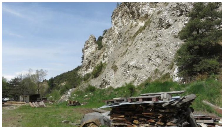
Photo 31 : Falaise de gypse surmontant le site dégradé
