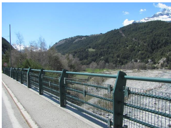
Photo 48 : Vue 2, depuis le pont
